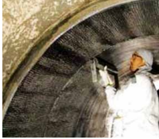
Şekil 5. Beton Bir Boruda İçeriden Karbon LP Uygulaması (Fyfe Co ve Fibrwrap LLC'nin izni ile)
